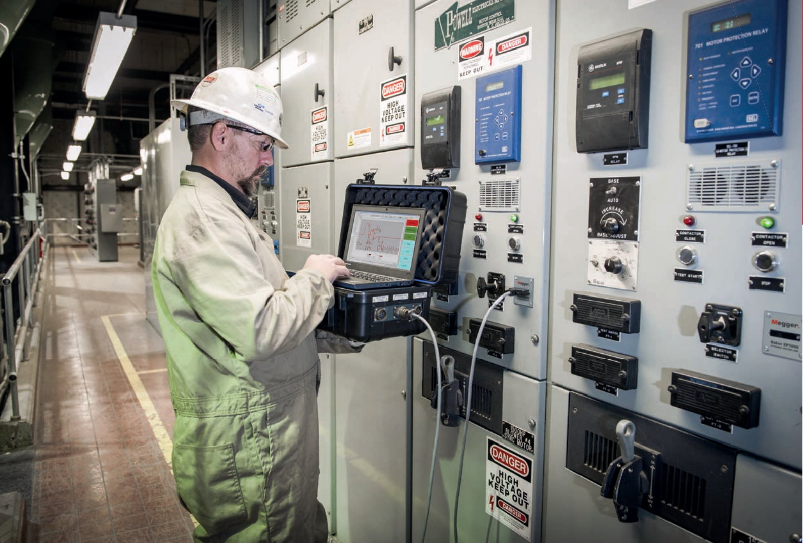
Техник работает с анализатором EXP4000, подключенным к порту блока связи EP1000 на щите управления ЩУЭ.
