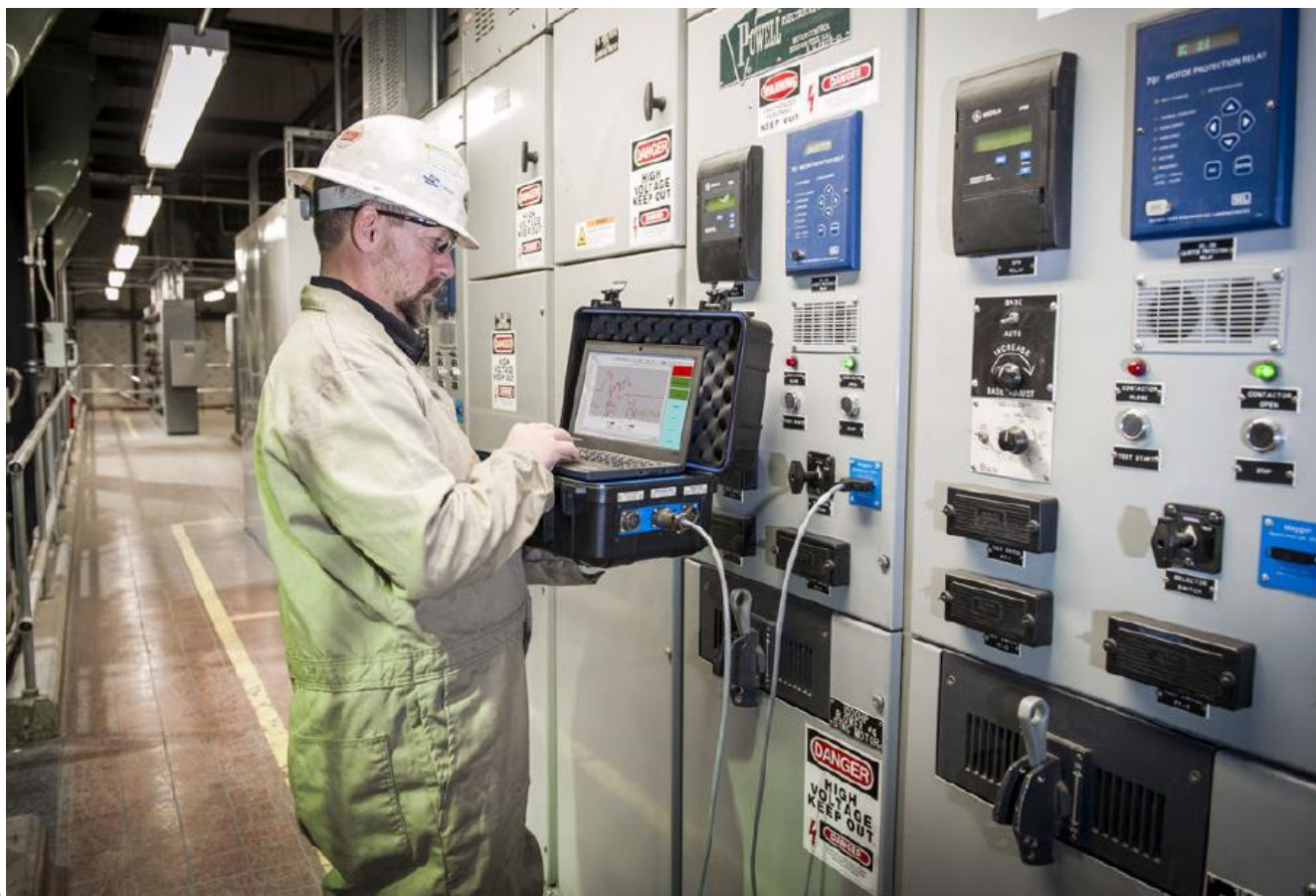
Техник работает с анализатором EXP4000, подключенным к порту блока связи EP1000 на щите управления МСС.
